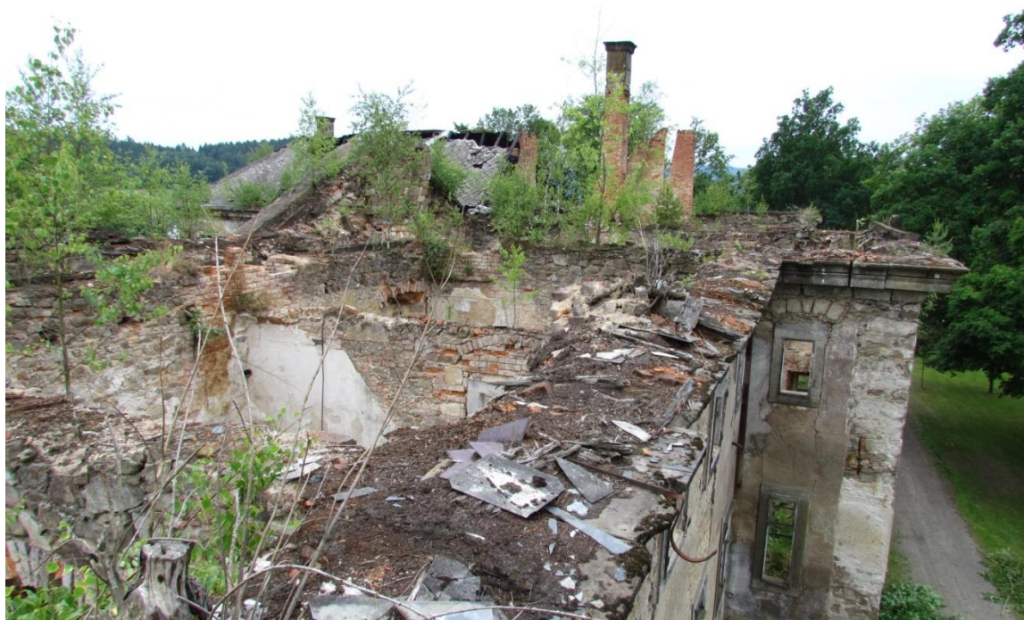
Pohled na korunu zdiva severozápadního nároží zakončenou kamennou římsou stav rok 2019 při likvidaci náletových dřevin
