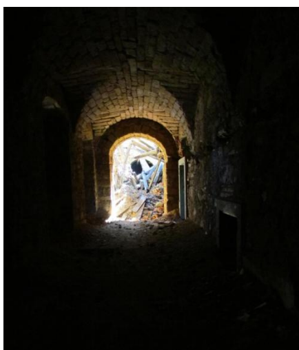
Pohled na spojovací chodbu před vyklizením a pohled na přilehlou místnost při sanaci zhroutených dřevěných konstrukcí a před vyklizením suti.
