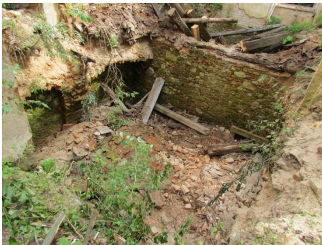
Tentýž pohled po zahájení sanačních prací
