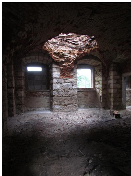
Vyklizená místnost napravo od vstupu
